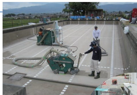
プールの底の除染をしています
