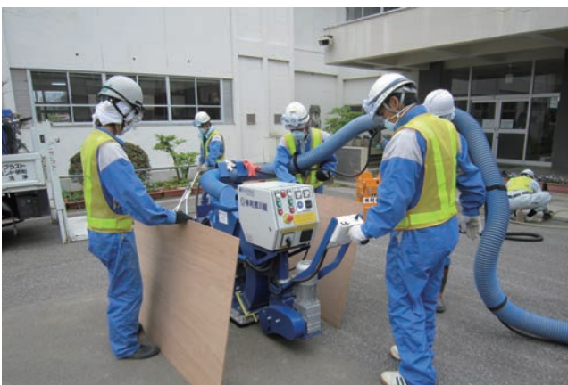
アスファルトの表面を取り除いています
