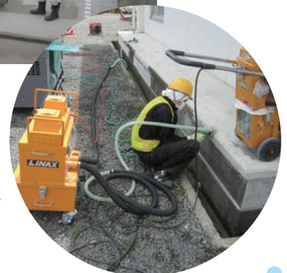
建物をみがき、表面を除染しています
